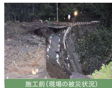
施工前(現場の被災状況)
