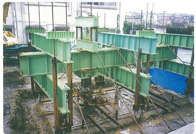
■ 高耐力マイクロパイル研究会 実大杭載荷試験 1999年1月
