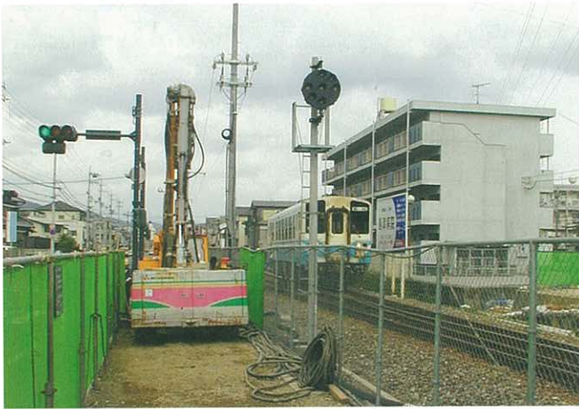
■ 薊野駅跨線橋新設工事 2002年4月
