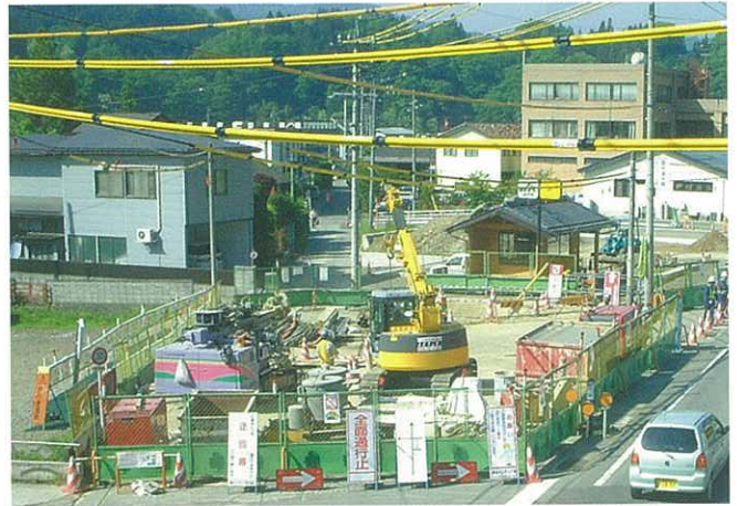
■ 里穂川横断歩道橋工事 2005年5月
