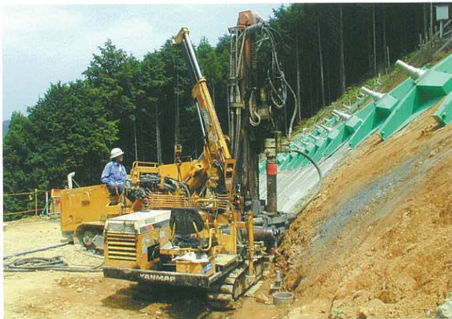
■ 宮崎10号寺畑第二トンネル工事 2001年8月
