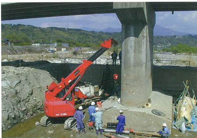
■大武川第44床固工事 2003年4月
