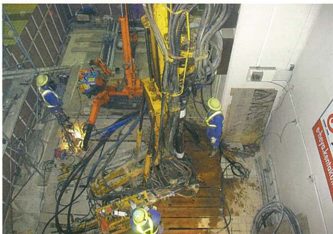
■ 東北新幹線古川駅エレベータ新設工事 2008年6月
