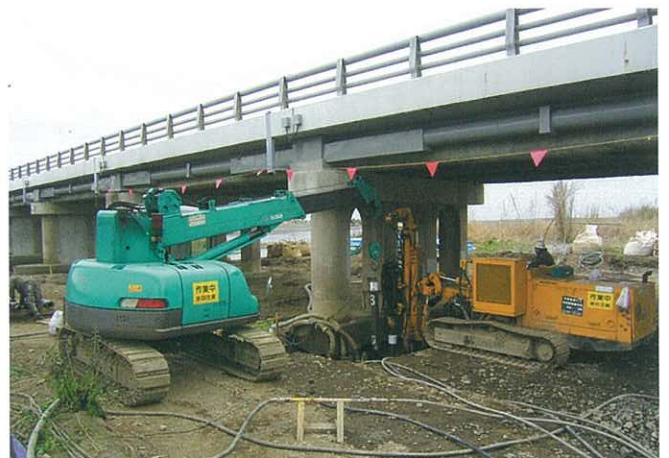
■42号南部大橋耐震補強工事 2004年11月
