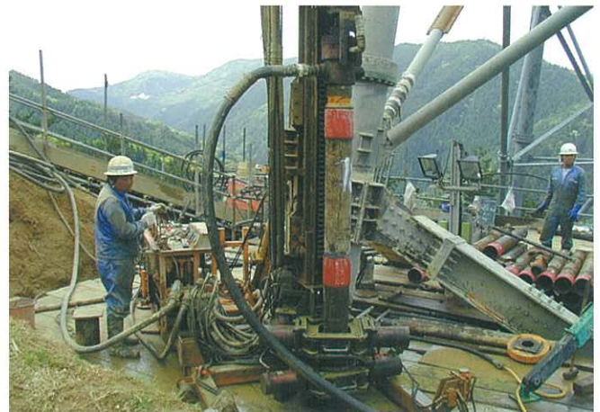
■ 中国電力中国中幹線、日野幹線鉄塔補強工事 2001年2月
