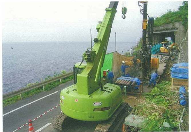
■ 国道269号道路改築工事 2004年4月
