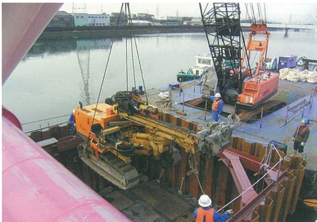
■ 第2天白水管橋下部工耐震補強工事 2006年2月
