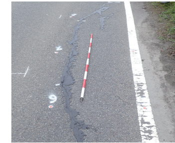
路面クラック
