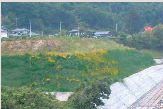
国道140号道路改良工事 (山梨県)
