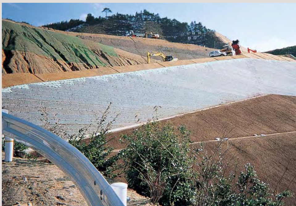
国道313号線山口改良工事（国土交通省）
