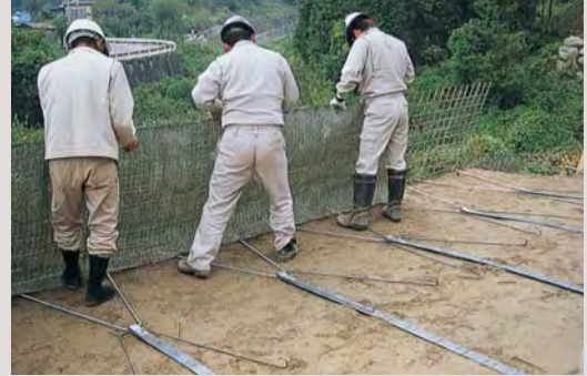
メッシュパネル組み立て・植生材取付け
