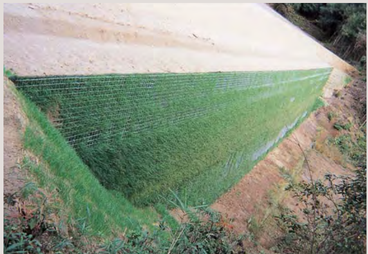
丸岡公園整備工事 (鹿児島県)
