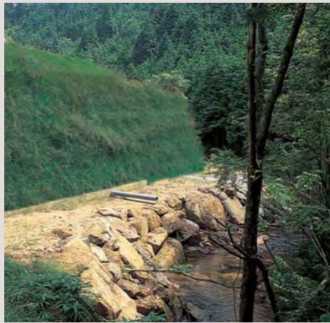
ふるさと林道 牧杉谷線開設工事 (滋賀県)
