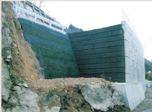
川本波多線工事 吾郷工区新世紀道路改良工事 (島根県)
