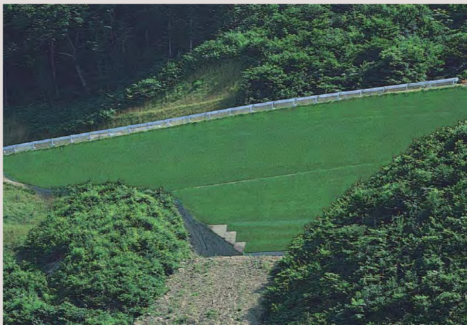
市道付替黒沢烏川線工事（国土交通省）
