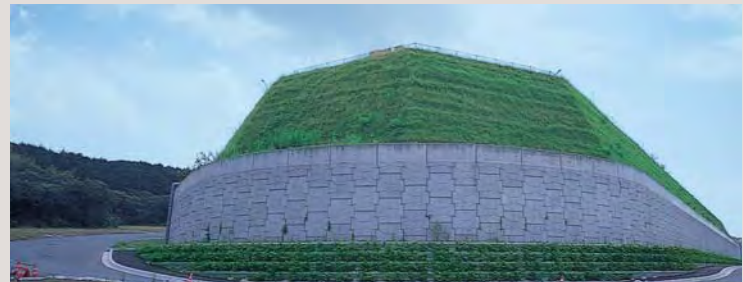
宇賀清掃工場敷地造成工事 (高知市)
