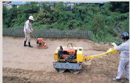
盛土材のまきだし・敷きならし・締め固め
