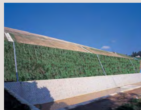
下山村健康福祉施設用地造成工事（愛知県下山村）
