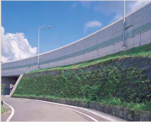
第207工区 御笠川下部工事 (福岡県)
