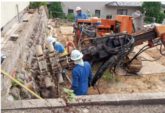
石積み擁壁引張補強打設状況
