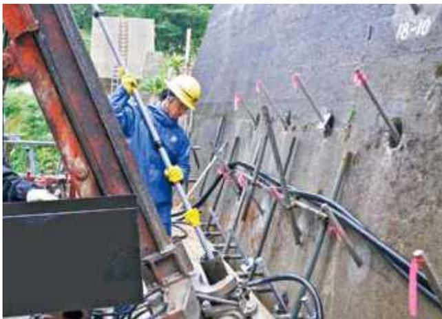
コア削孔によるEPルートパイルの打設
