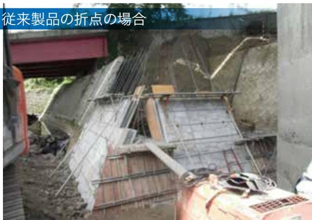
コンクリートカッターにより前面パネル加工
