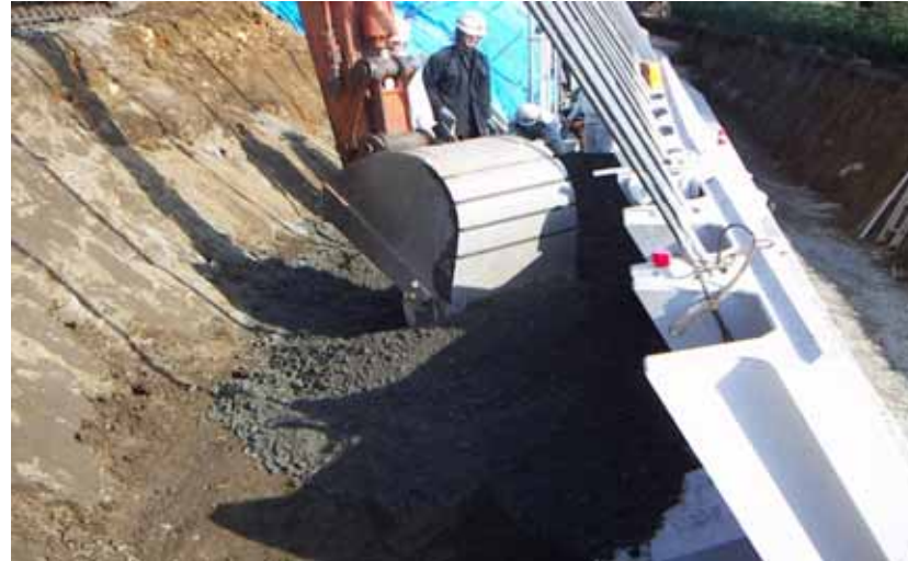
胴込め材撒きだし、出来形300層厚にて転厚
