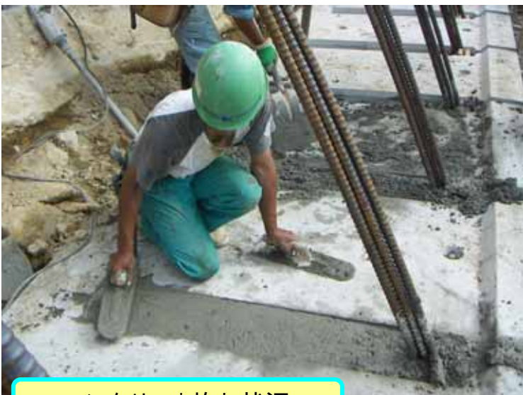
コンクリート均し状況
