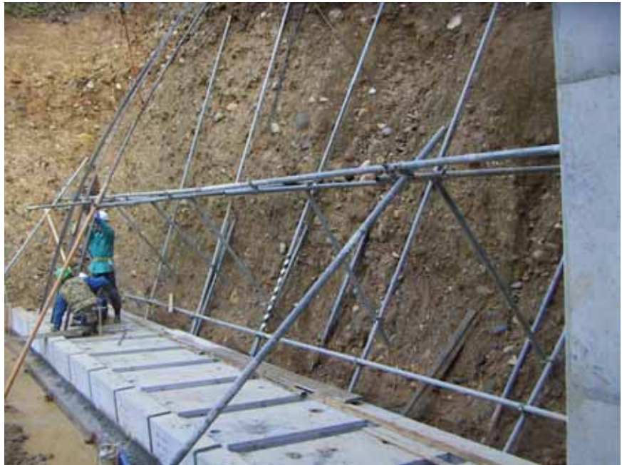
基礎ブロック設置後全景
