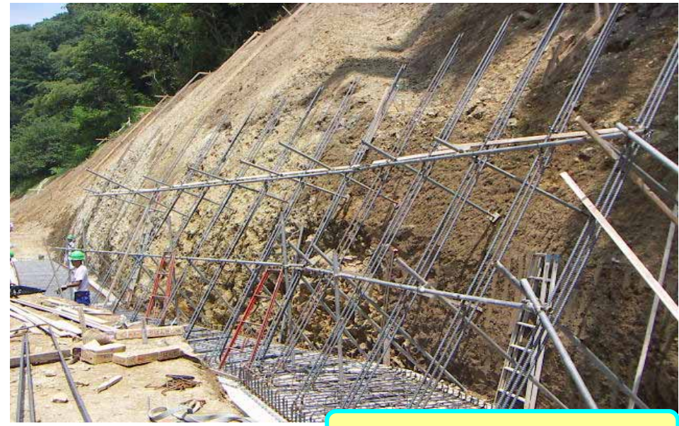
縦貫鉄筋設置後全景
