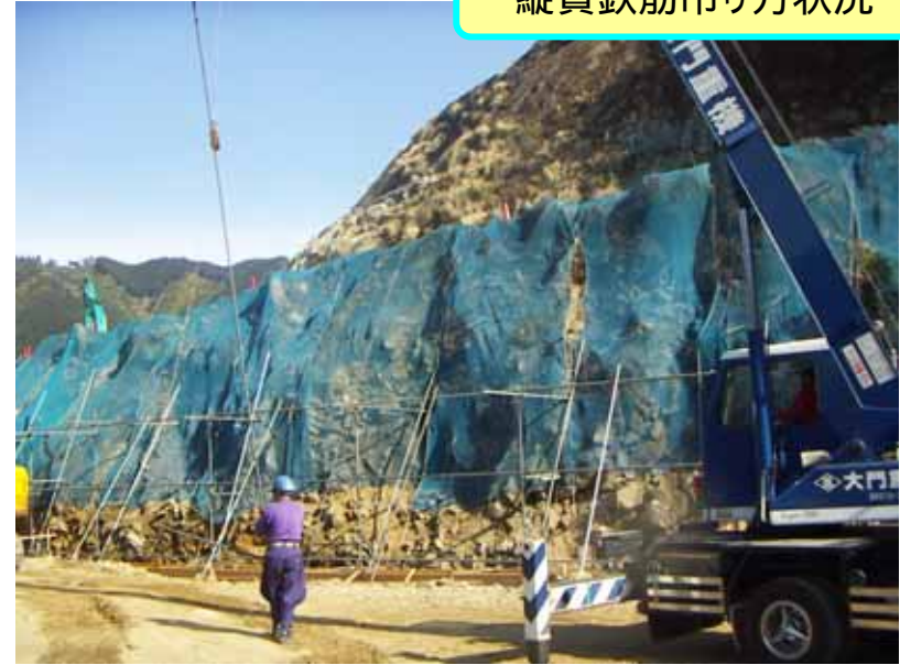
縦貫鉄筋吊り方状況
