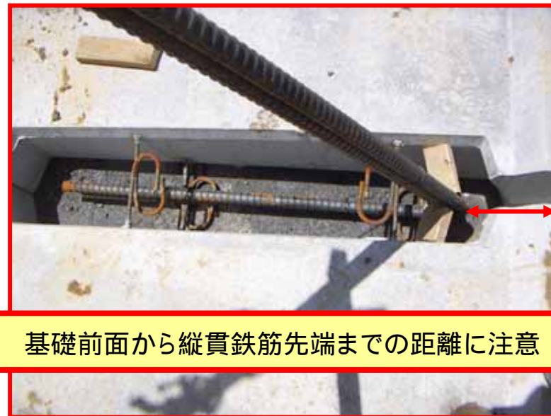
縦貫鉄筋設置作業状況
