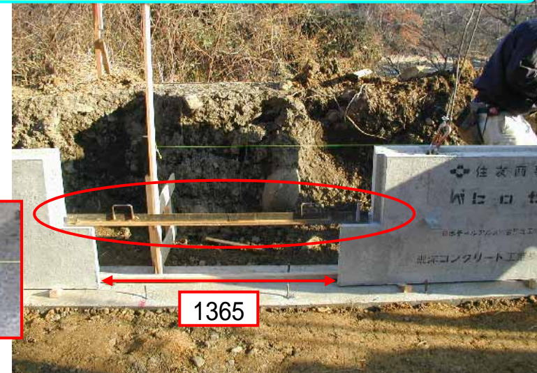
建て込み定規1500mmでピッチ寸法確認
