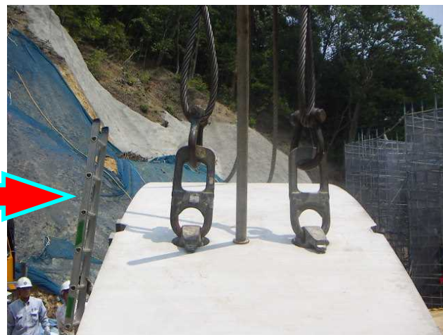
部材を所定の位置に設置しクサビで固定
