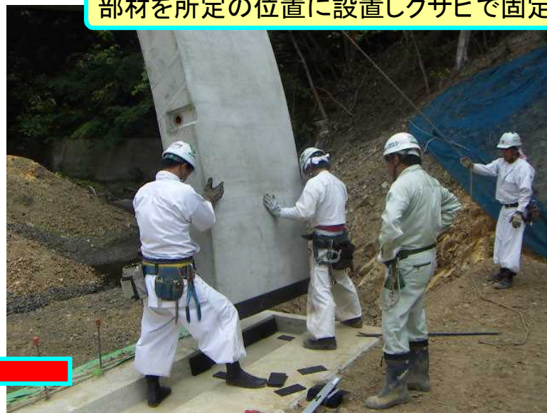
部材を所定の位置に設置しクサビで固定
