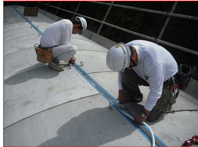
バックアップ材装填
