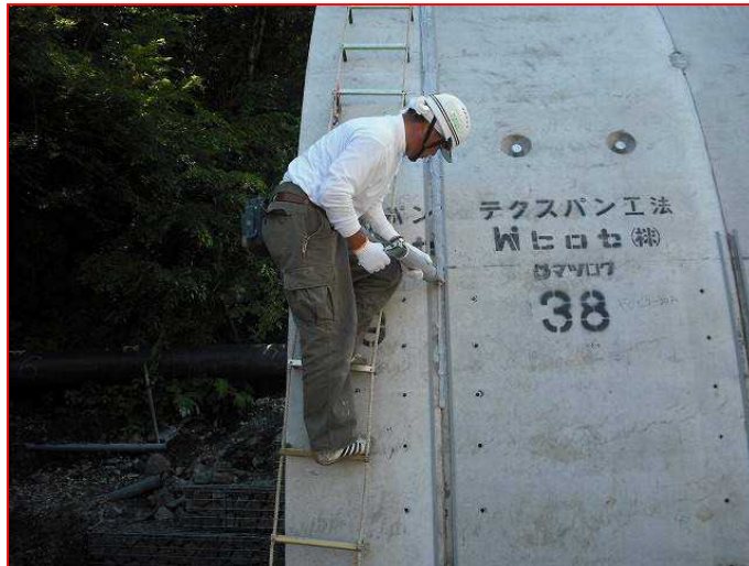
プライマー塗布・シーリング材の充填
