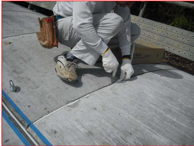
バックアップ材の装填
