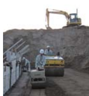
土のまき 出し・転圧
