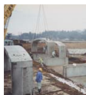
アーチ部材の組立
