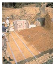
土のまき 出し
