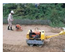
敷きならし 盛土材のまきだし 締め固め
