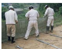
メッシュパネル 組み立て 植生材取付け
