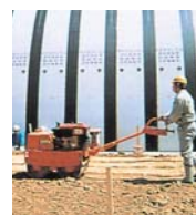
盛土工事 坑口工事
