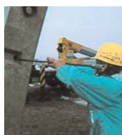
坑口部の 連結工
