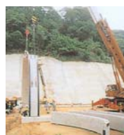
アーチ部材の 組立
