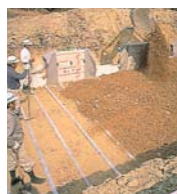
土のまき 出し
