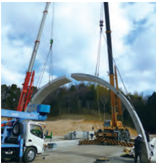
支保工を用いた施工
