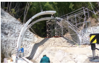
支保工を用いた施工
